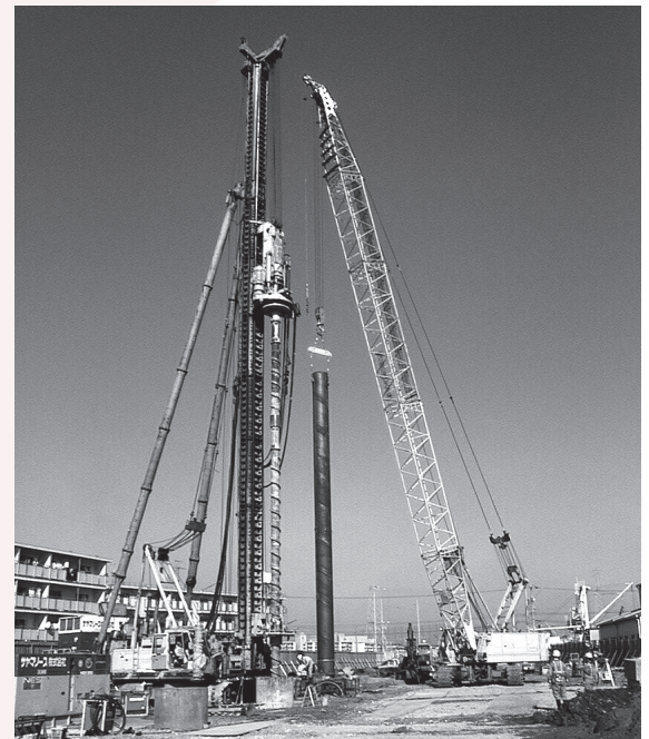
鋼管ソイルセメント杭工法 [HYSC (ハイエスシー)] 沈設風景
