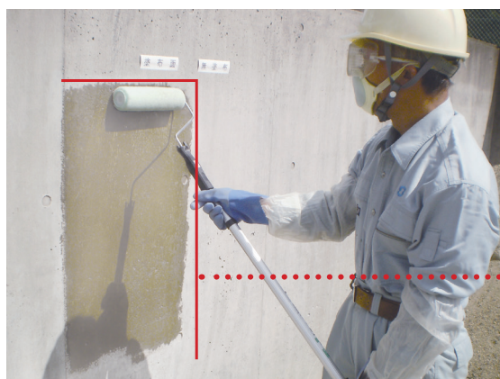
ローラーによる作業状況
