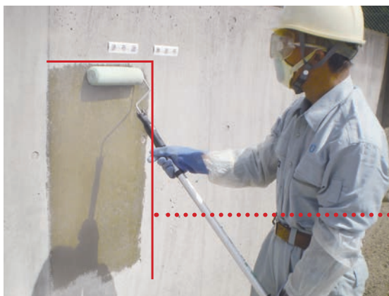
ローラーによる作業状況
