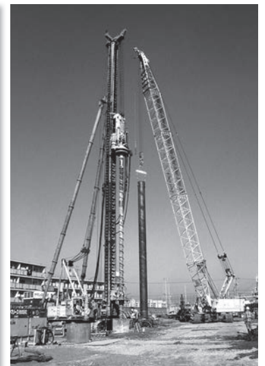
鋼管ソイルセメント杭工法 [HYSC工事(ハイエスシー)]沈設風景
