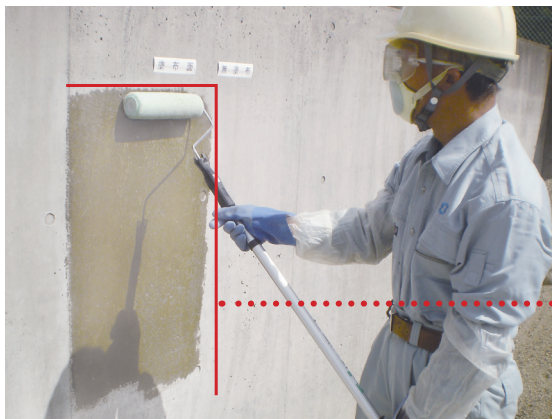
ローラーによる作業状況
