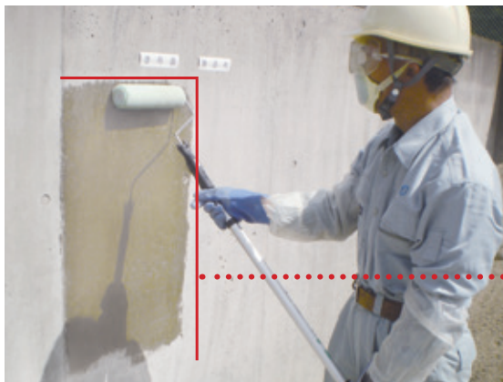
ローラーによる作業状況
